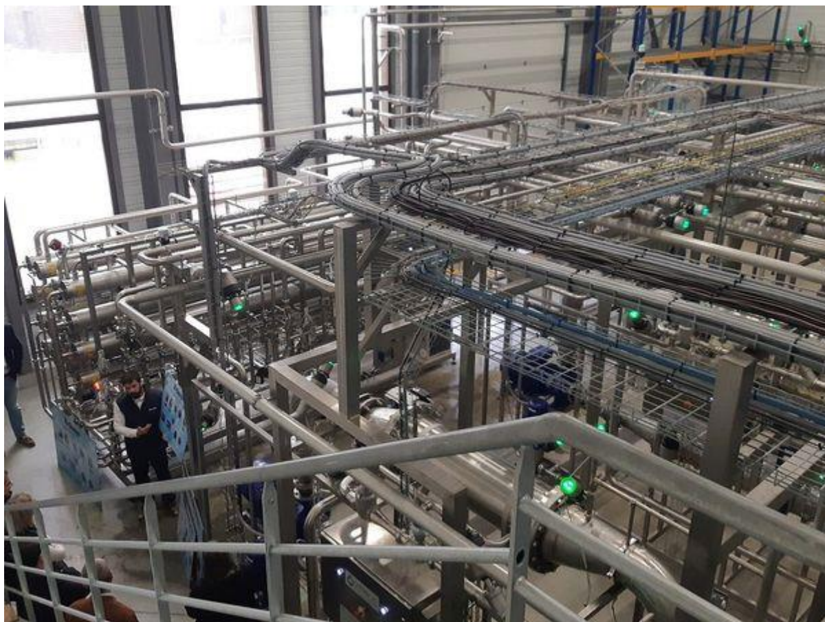
LIFE ZEUS, LE PROCÉDE DE FILTRATION EST COMPOSÉ DE MILLIERS DE TUYAUX ET DE MEMBRANES DE FILTRATION © RADIO FRANCE - MICHEL BENOIT
