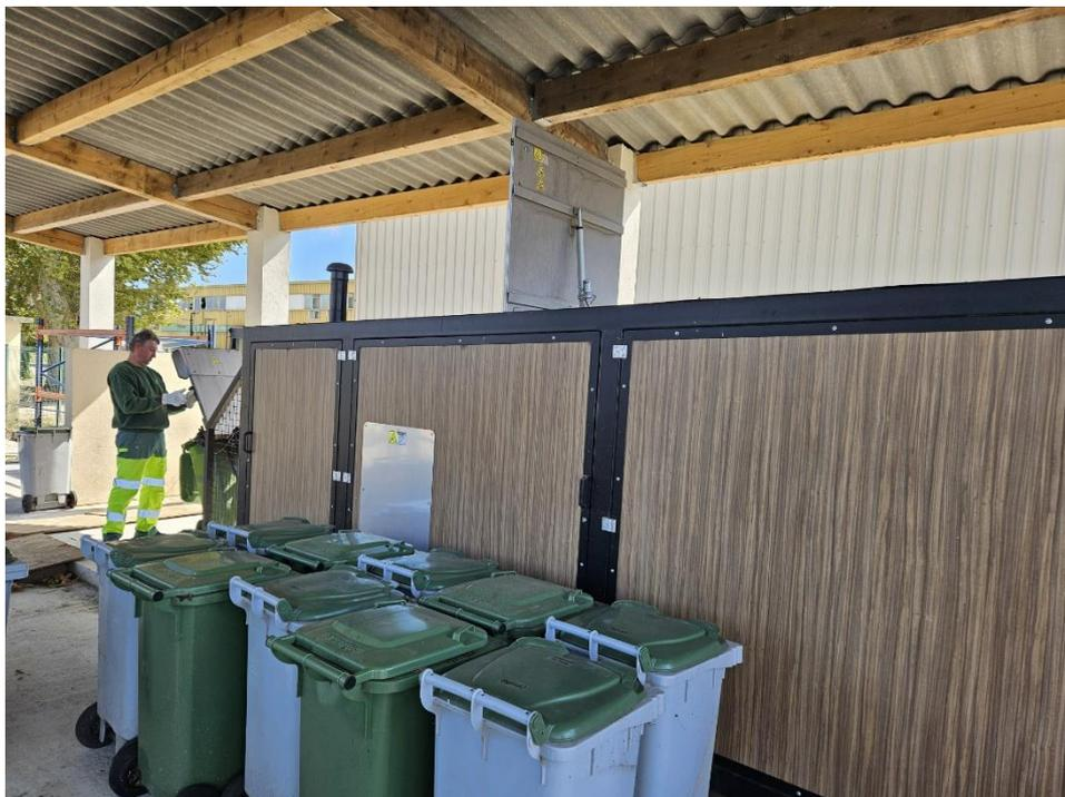
(D. Ghidoni) - Le composteur fonctionne en flux continu, il suffit de positionner les containers et la trappe s'ouvre pour recevoir les biodéchets.
